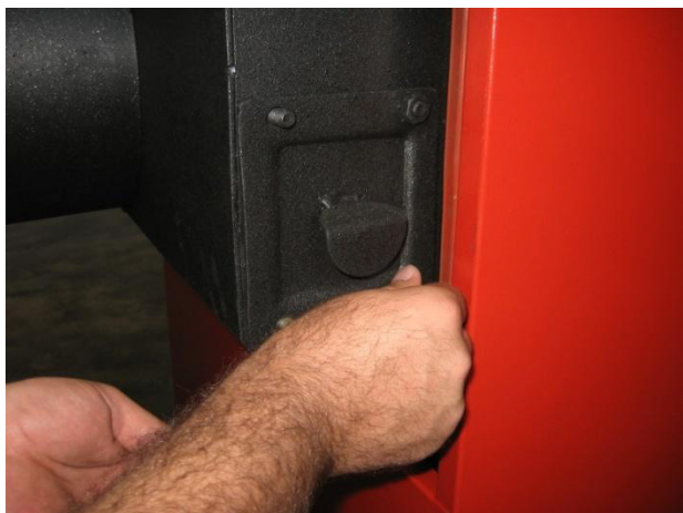
Рис. 9. Снятие заглушки для чистки адаптера дымохода.
